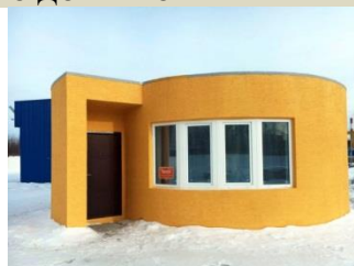
Рис. 2. Современная практика строительства 3D-принтером [10–15]
