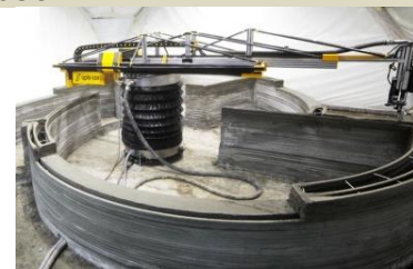
Рис. 2. Современная практика строительства 3D-принтером [10–15]
